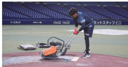
マウンドはピッチングにより荒れた部分の土を削り取った後、新たな土を補充。転圧機と呼ばれる機械でしっかりと固めます！
