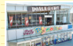
オープンデッキ8ゲート付近
