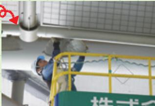
高所作業車に乗り込んだ作業員が古い照明を次々に取り外し、新しい照明をセットしていきます。
